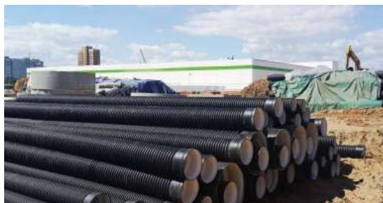
Объект: ТЦ «Акварель», Краснодарский край Поставщик: ООО «Спецстрой»
