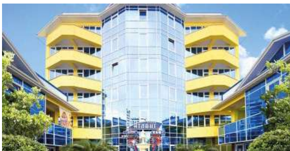
Объект: Гостиница «Атлант», г. Сочи Поставщик: ООО «Теплосервис»
