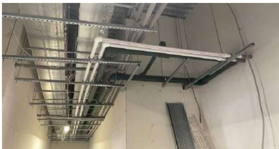
Объект: Строительство многофункционального медицинского центра ГУ «Луганская республиканская клиническая больница» Поставщик: ООО «Труботорг»
