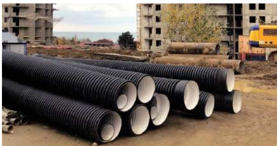
Объект: Жилой комплекс «Морская симфония», г. Сочи Поставщик: ООО «Агора»
