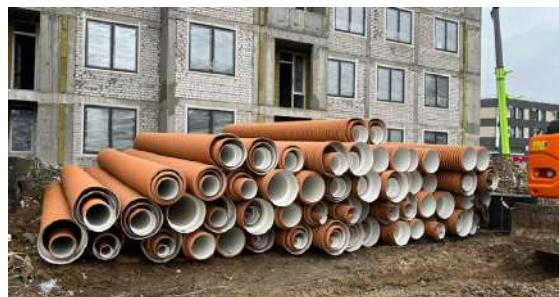
Объект: ЖК «Открытие», г. Казань, ул. Аделя Кутуя Поставщик: ООО «ТФ Пласт»
