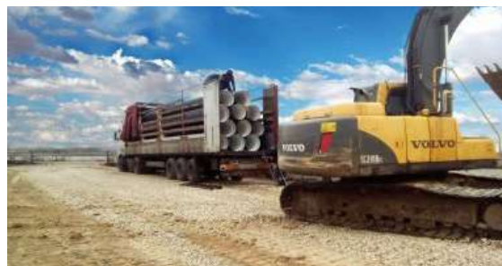
Объект: Прокладка ливневой канализации, г. Унеча Поставщик: ООО «Фланец-Комплект»
