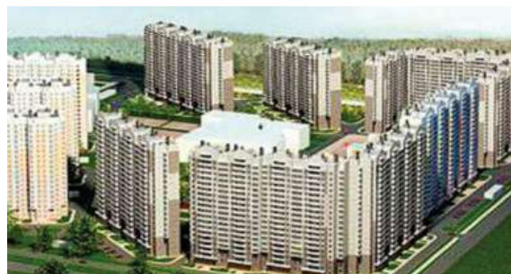
Объект: ЖК «Каменка», г. Санкт-Петербург, 78 квартал, мкр. Каменка Поставщик: ООО «Денеб»
