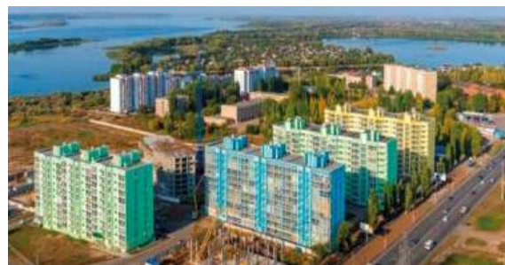
Объект: ЖК «Волжский изумруд», г. Энгельс, ул. Студенческая Поставщик: ООО «Сантехкомплект»
