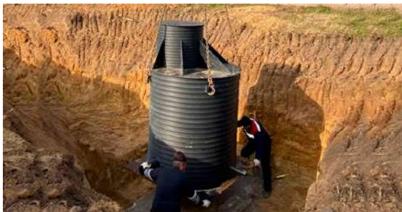
Объект: Завод холодильного оборудования, Щёлковский район, д. Богослово Поставщик: ООО «Простор-Л»
